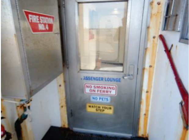
Superstructure access door
